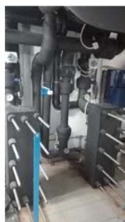
Slika lijevo: međuzmjenjivač Slika gore: pumpe podzemne vode
